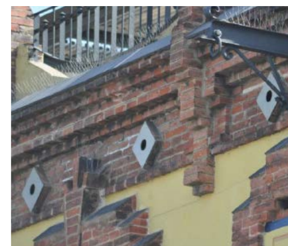
Adaptació de forats per a gralles. Fàbrica del Sol
