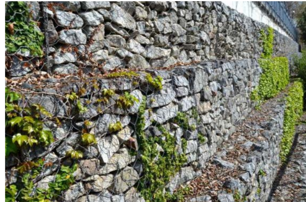
Gabions al Parc de les Aigües
