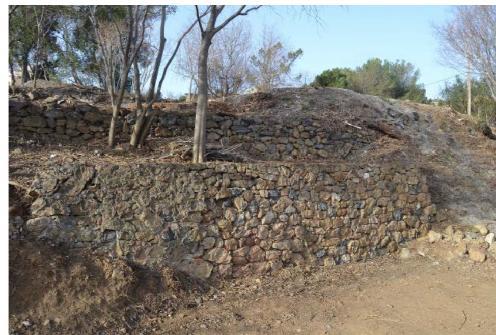
Murs de pedra a Mas Ravetllat
